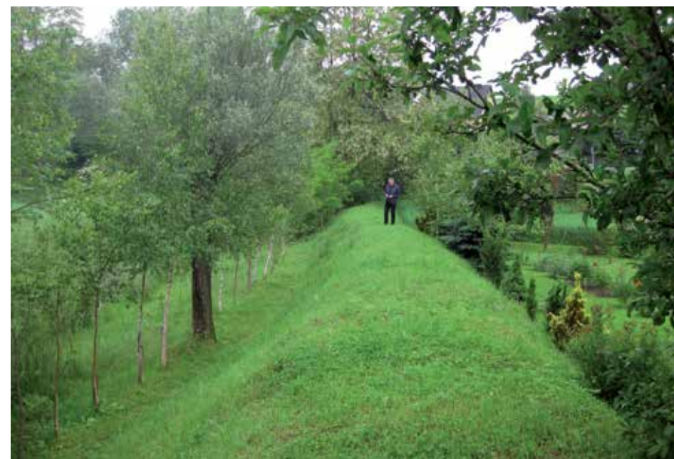
PRYWATNY WAŁ USYPANY WOKÓŁ ZABUDOWAŃ MA CHRONIĆ PRZED SKUTKAMI WEZBRANYCH WÓD PRZEPŁYWAJĄCEJ TUŻ OBOK, A NIEPOZORNEJ NA CO DZIEŃ, RZECZKI | FOT. ARCHIWUM R. KONIECZNEGO
